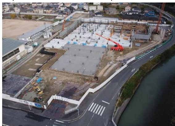
◀全体写真 (敷地北側から) 10月27日撮影
