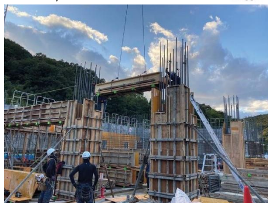
1階躯体工事▶ (型枠工事) 10月28日撮影
