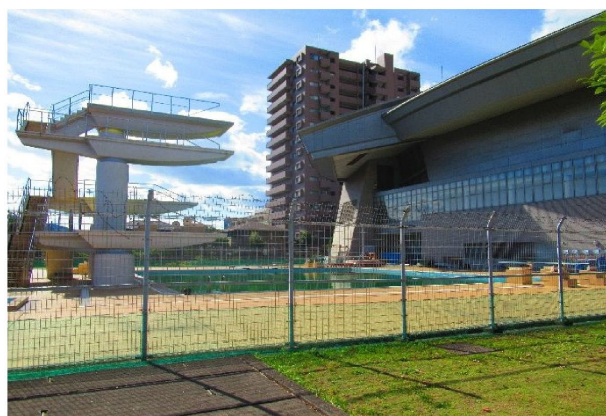
⑱飛込プール
