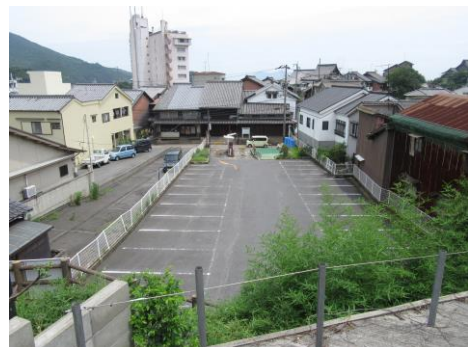
市営鞆の浦駐車場
