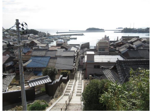
保存地区内は低層（2階以下）の建築物が大半を占める 木造建築物の中に非木造建築物が点在する区域
