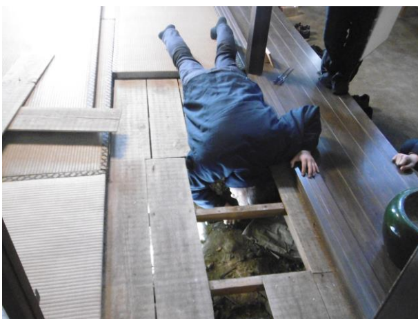
床下・基礎の調査
