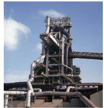
【鉄鉱石から溶かして 鉄を取り出す】
