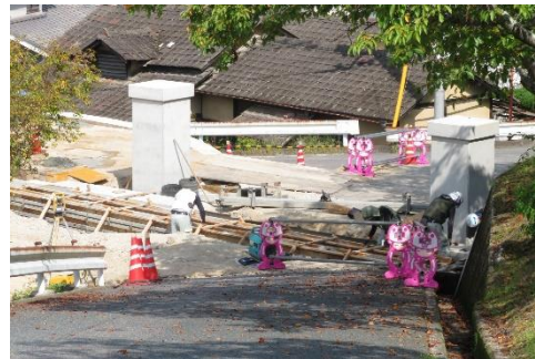
【バス乗降所整備】工事中の校門
