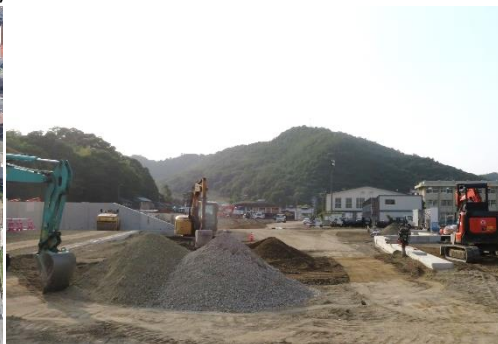
校舎新築工事
