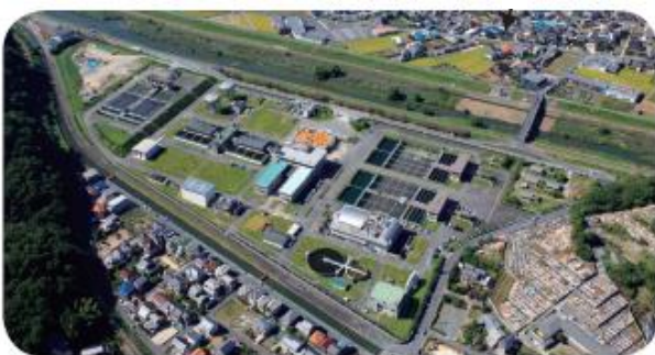
〔中津原浄水場〕
