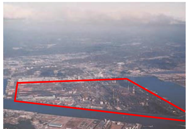
〔埋め立てによりできた工場用地〕
