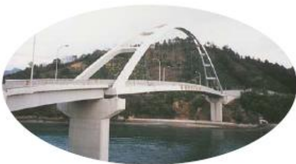
〔岡村島への橋〕
