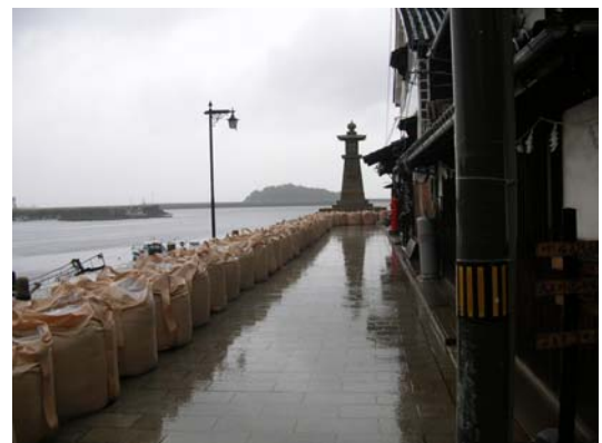
高潮に備え土のうを設置
