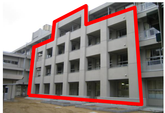
【曙小学校北棟耐震補強工事】
