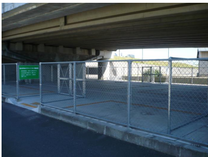
【山手橋立体橋下に整備した駐輪場】
