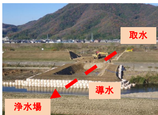
【導水管布設・布設替工事】
