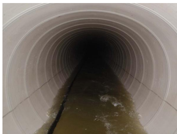
【下水道管渠耐震化工事完成】
