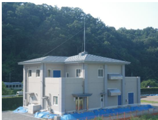
【管理棟築造工事】
