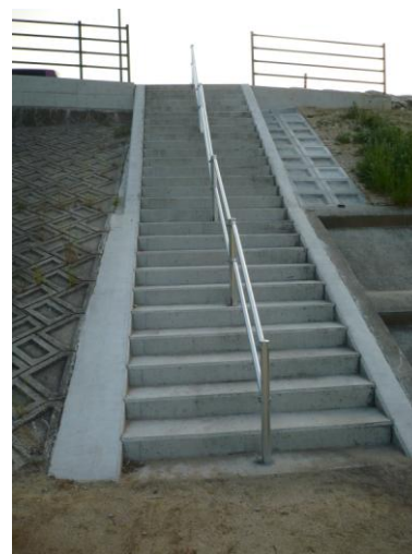
【進入用階段に手すりを設置】
