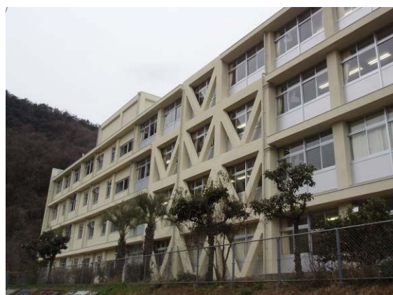
【校舎耐震補強工事(2011年度(平成23年度)実施箇所)】
