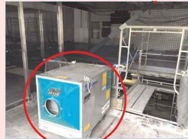
集塵機を設置し室内の換気を実施
