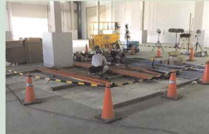
工事エリアの区画を設定して作業
