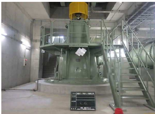
新涯ポンプ場ポンプ設備工事
