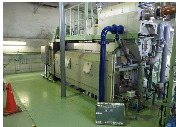
松永浄化センター汚泥処理棟機械設備工事
