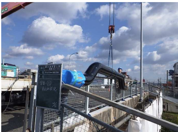
配水管布設工事
