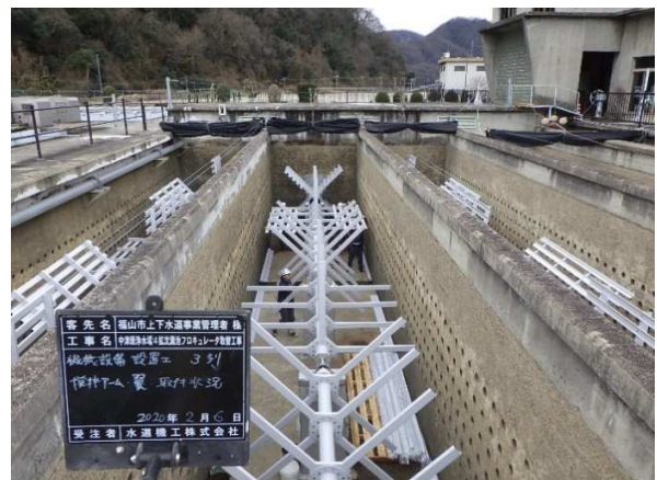
中津原浄水場4拡沈澱池フロキュレータ取替工事
