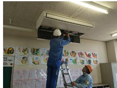
【小中学校への空調設備整備】
