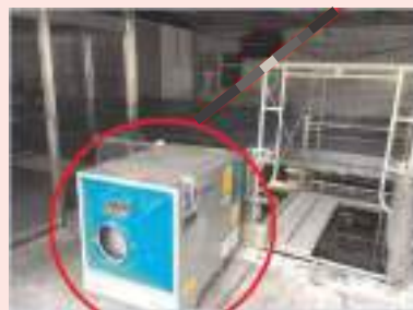
集塵機を設置し室内の換気を実施
