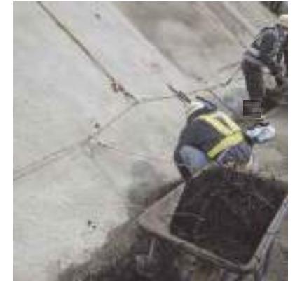
作業時なるべく離隔を確保
