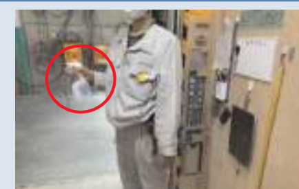
EVの操作盤等の消毒を徹底
