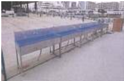
現場の手洗い場所の増設
