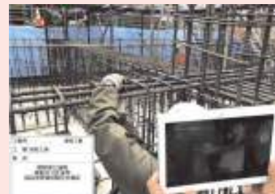
Webカメラを利用した遠隔検査
