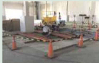
工事エリアの区画を設定して作業
