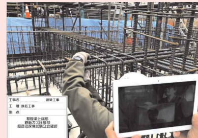
Webカメラを利用した遠隔検査
