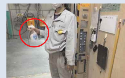
EVの操作盤等の消毒を徹底
