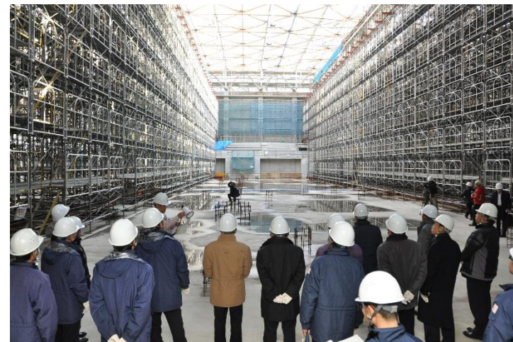
【総合体育館（メインアリーナ）の工事現場】
