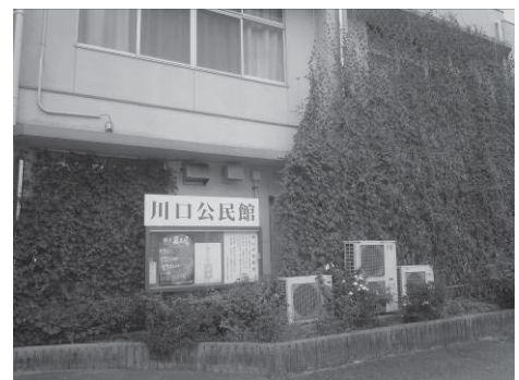
グリーンカーテン設置
