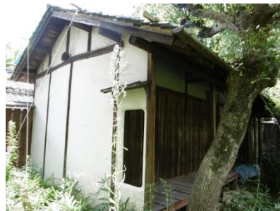
祠堂（シートによる養生）
