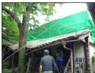
④米蔵（この辺りでは外部はほとんど見えない）
