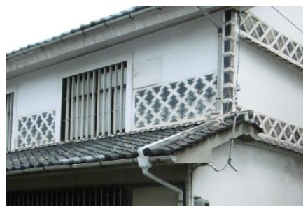
従前建物の部材（格子）を新築建物に利用。新築建物に伝統的な意匠を一部取り入れる
