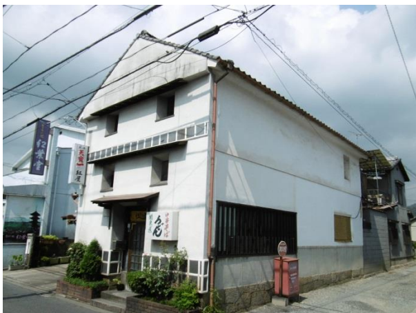
土蔵を店舗として再生・活用
