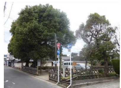
⑥南東側から見た表門付近
