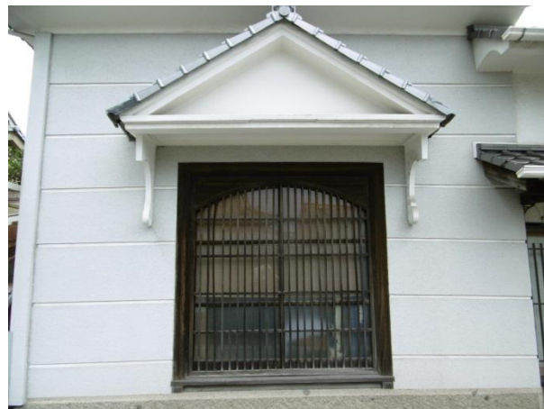
従前建物の部材（格子）を新築建物に利用。新築建物に伝統的な意匠を一部取り入れる
