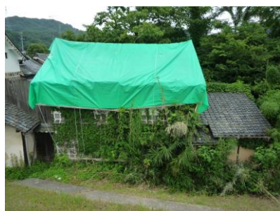
米蔵（シートによる養生）
