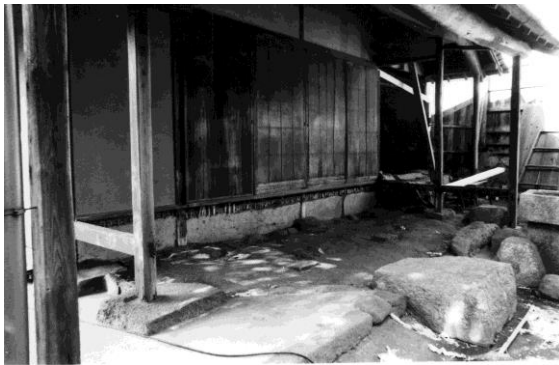
廉塾竹縁解体
