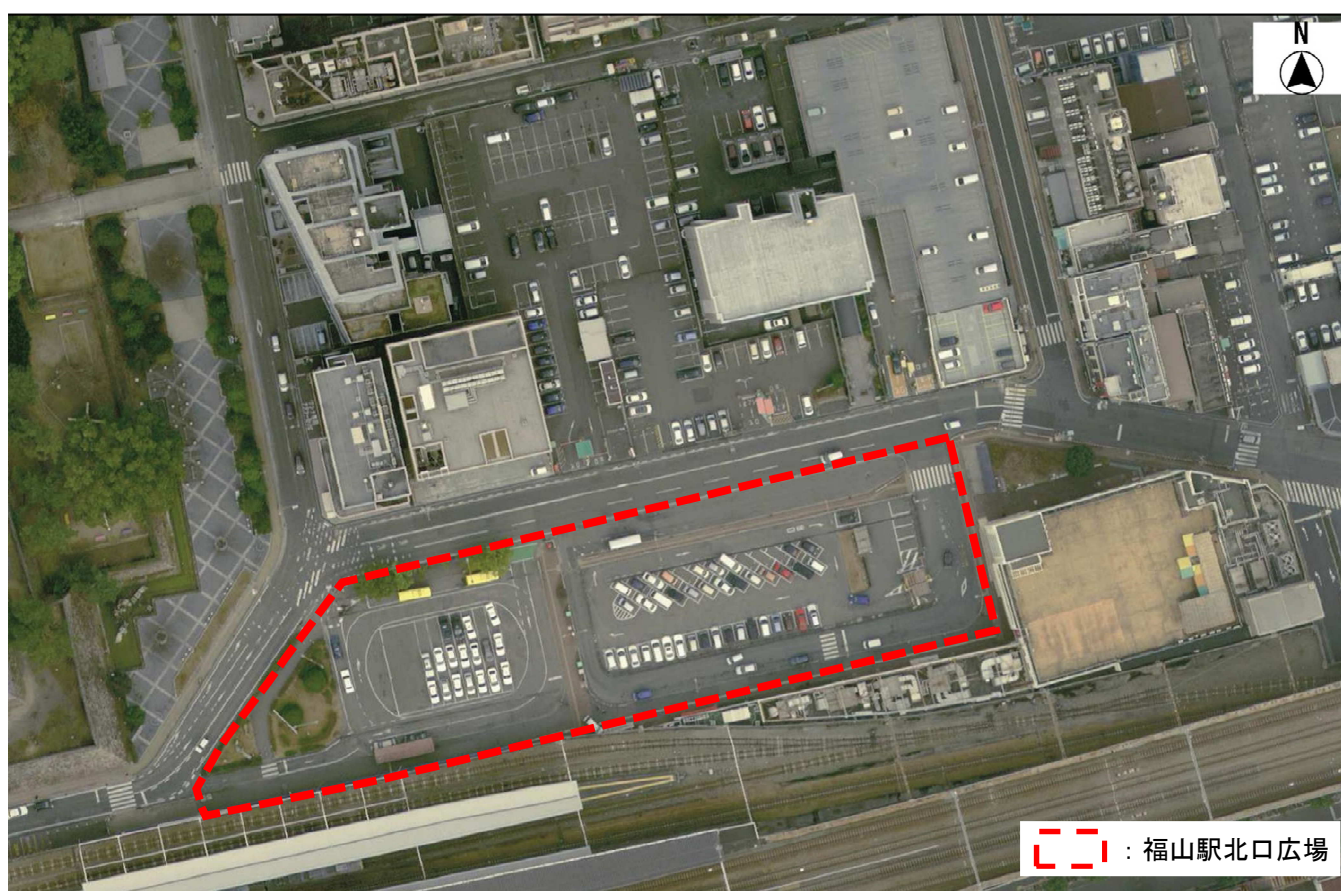
■福山駅北口広場及び周辺状況
