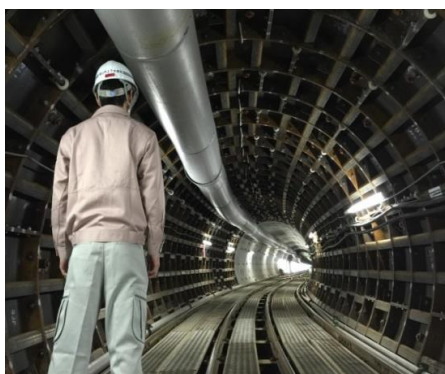
大型雨水幹線の整備(中央2号・中央5号幹線)
