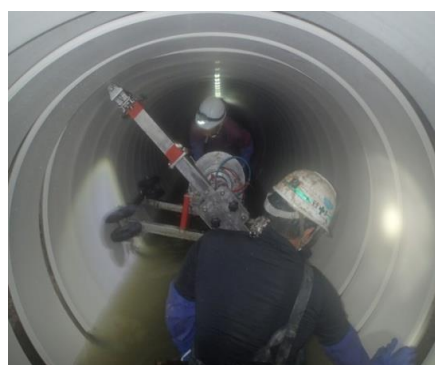
下水道施設の耐震化 ※既設管の中に、地震に強い管を新しく造る
